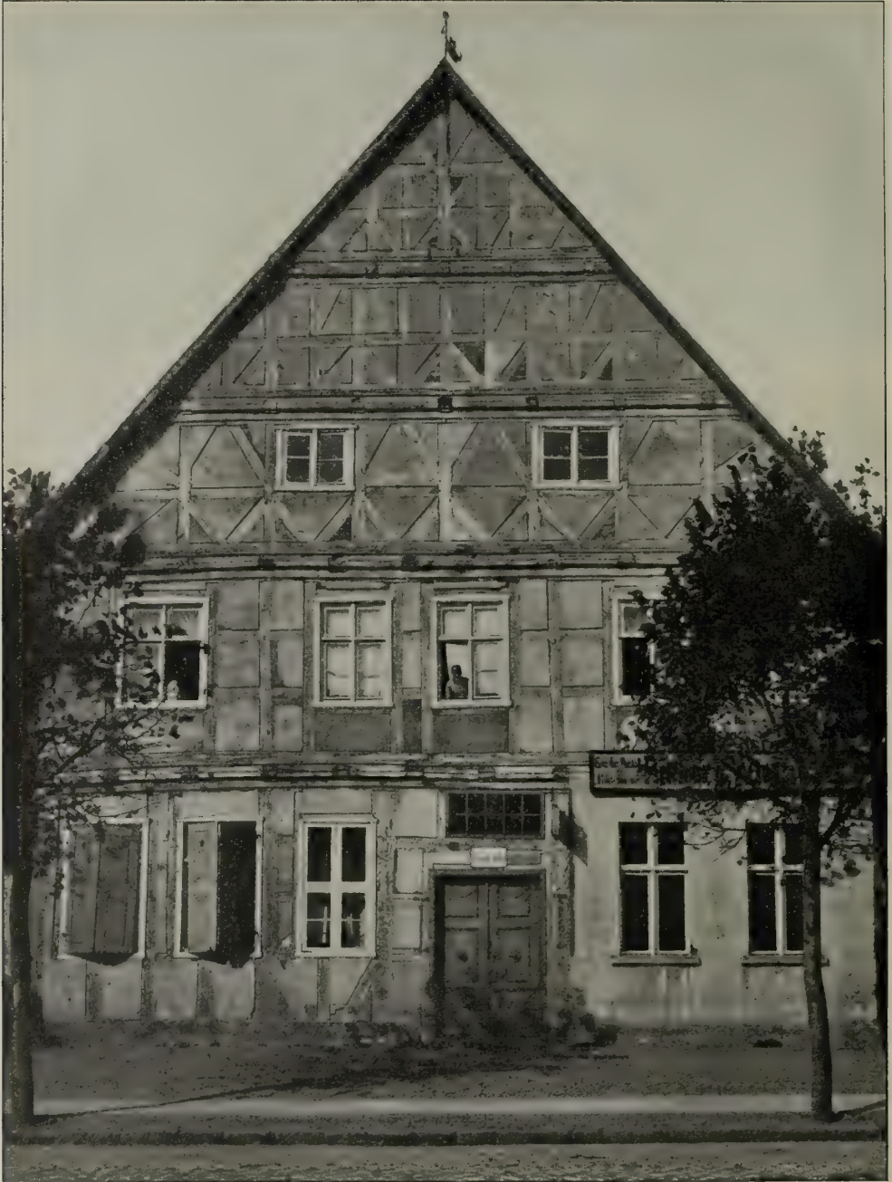
Fig. 173. Kyritz. Fachwerkhaus Wilhelmstr. 48.
